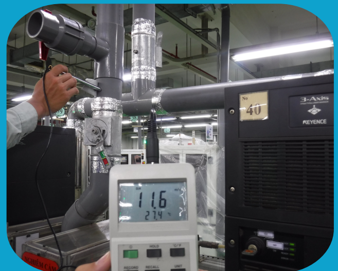
Hệ thống hút bụi
